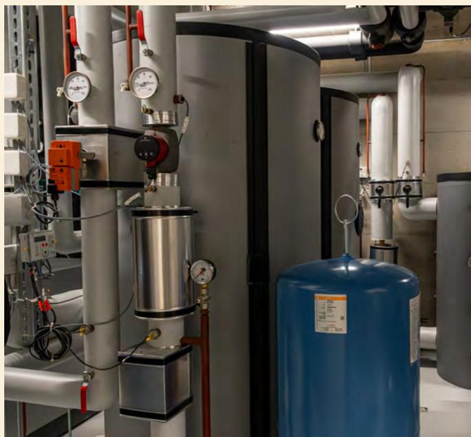
Pompes à chaleur installées dans notre nouvelle résidence de Gumefens. Système géothermie avec 9 sondes de 150 mètres de profondeur.
